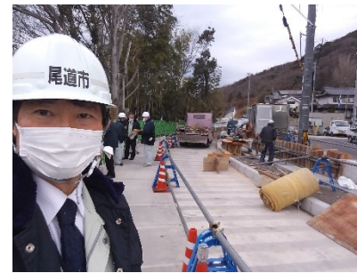
日比崎中学校前の道路拡幅工事(1月)
