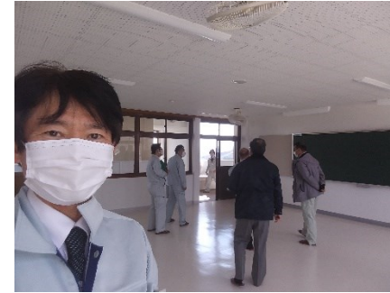
栗原中学校の校舎改修工事(2月)
