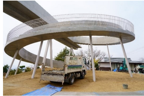
完成直前の千光寺公園頂上展望台(3月)
