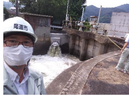
因島中庄町の油屋新開排水ポンプ場(7月)
