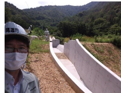
瀬戸田のため池柱谷池改修工事(7月)
